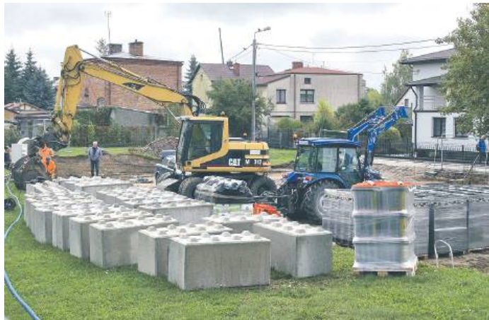
Przy SP nr 3 prace związane z budową hali już się rozpoczęły
