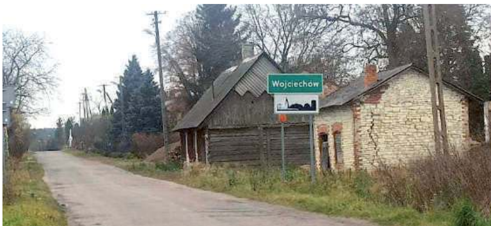
Droga biegnąca przez Wojciechów aż prosi się o remont. Ostatni był przeprowadzany w latach 90.
