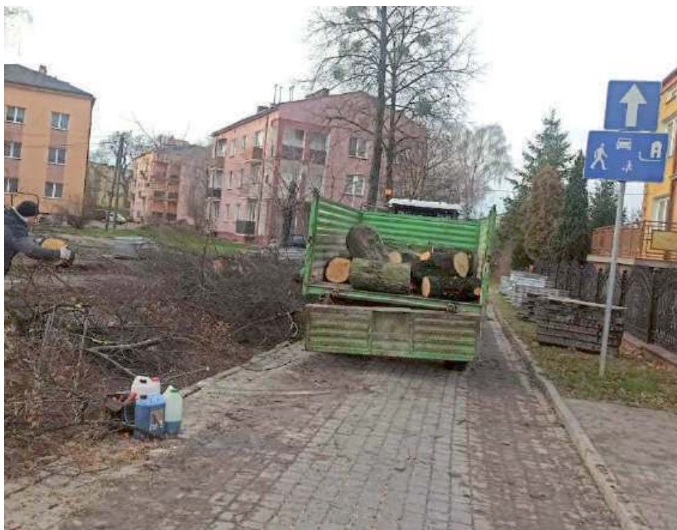
Na miejscu zastaliśmy pracowników usuwających pozostałości po wyciętym drzewie
