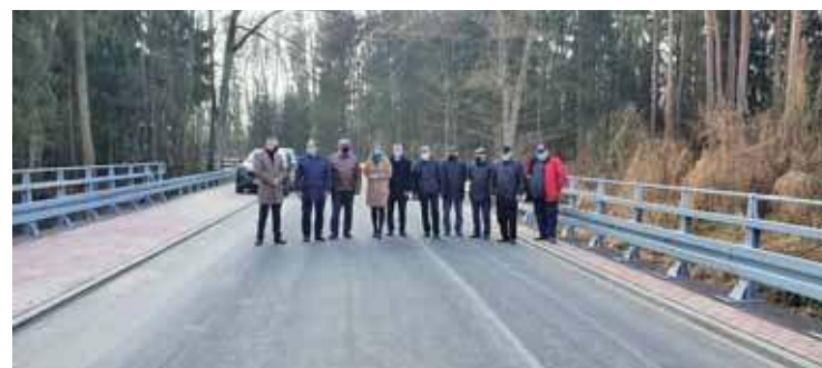
Przebudowa odcinka drogi i budowa mostu w Obrytem to jedna z ważniejszych inwestycji; tu odbiór drogi
