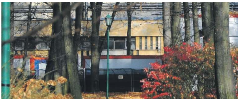
Widoczny zza drzew budynek starej kotłowni będzie wyburzany. Na jego miejsce stanie nowy pawilon szpitalny
