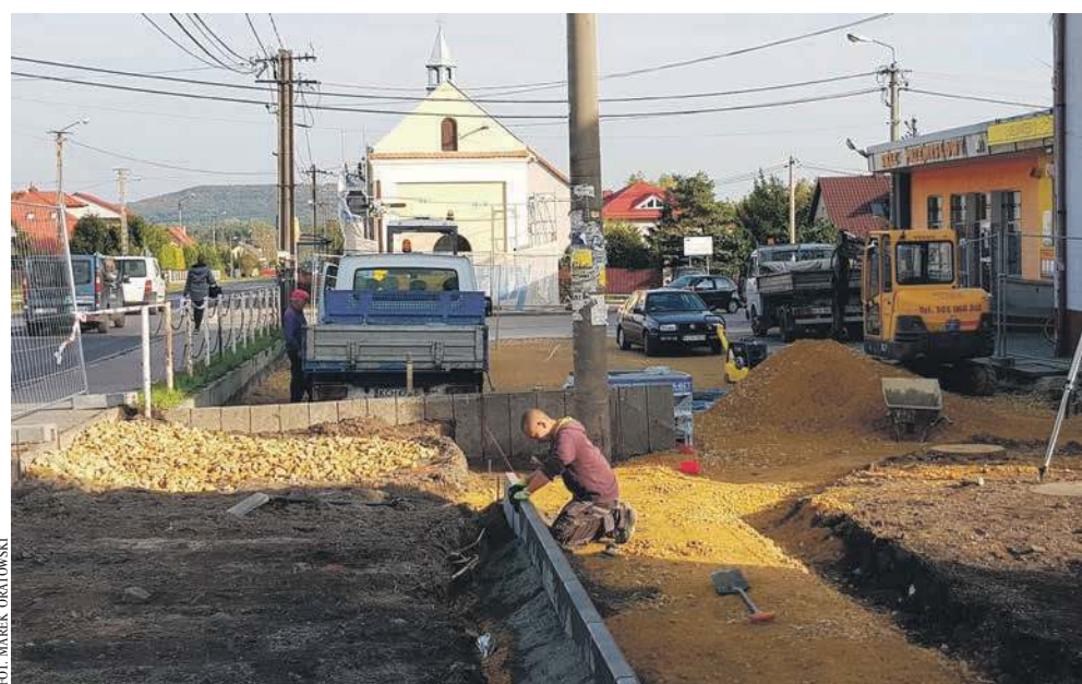
Prace w centrum Żarek trwają od połowy października
