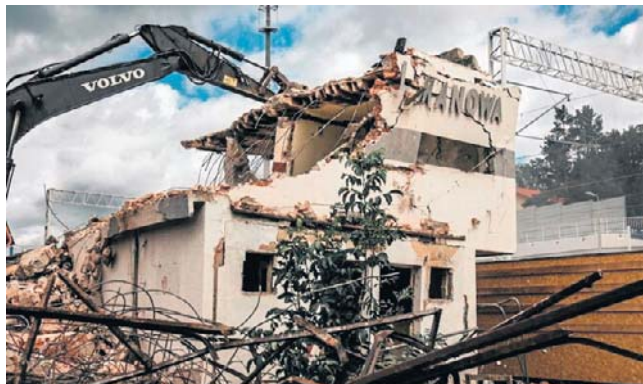
Budynek dworca kolejowego w Limanowej miał być modernizowany. W środę, 19 sierpnia, został rozebrany
