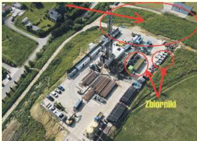
Zdjęcia z dnia 4.06.2025. Wykopu nie było, ale stoją zbiorniki
