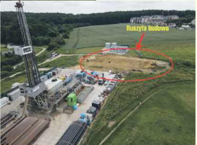
Zdjęcia z dnia 10.06.2025. Widać nowe prace ziemne
