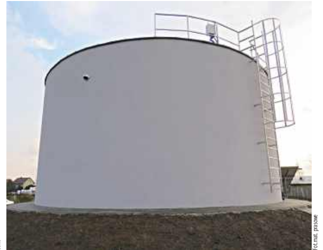
Dzięki tej inwestycji mieszkańcy gminy mogą cieszyć się lepszym bezpieczeństwem dostaw wody pitnej oraz nowoczesnymi rozwiązaniami technologicznymi
