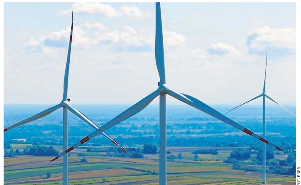
Transition Technologies-Systems i Enea wdrażają jeden z największych w Polsce systemów do zarządzania OZE i magazynami energii.
