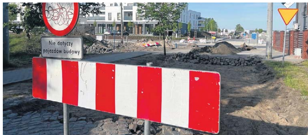
Prace na obecnym pierwszym odcinku, od ulicy Żwirki i Wigury do Skorupki, zakończą się w wakacje
