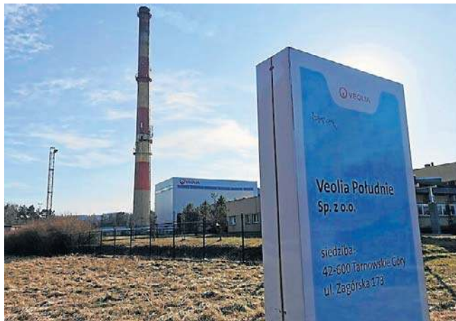
Veolia Południe nie rezygnuje z planów budowy Zakładu Odzysku Energii w Chrzanowie
