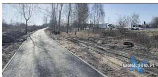
Budowa drogi rowerowej w Byczynie
