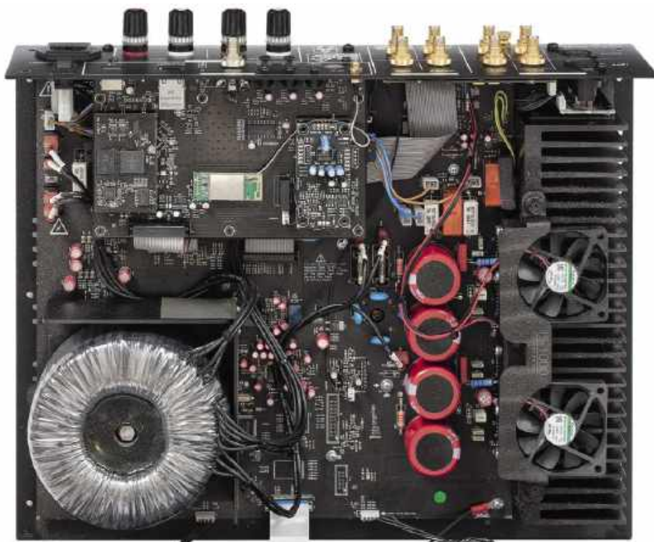
Wnętrze ma budowę modułową, która pomaga realizować koncepcję apgrejdów.
