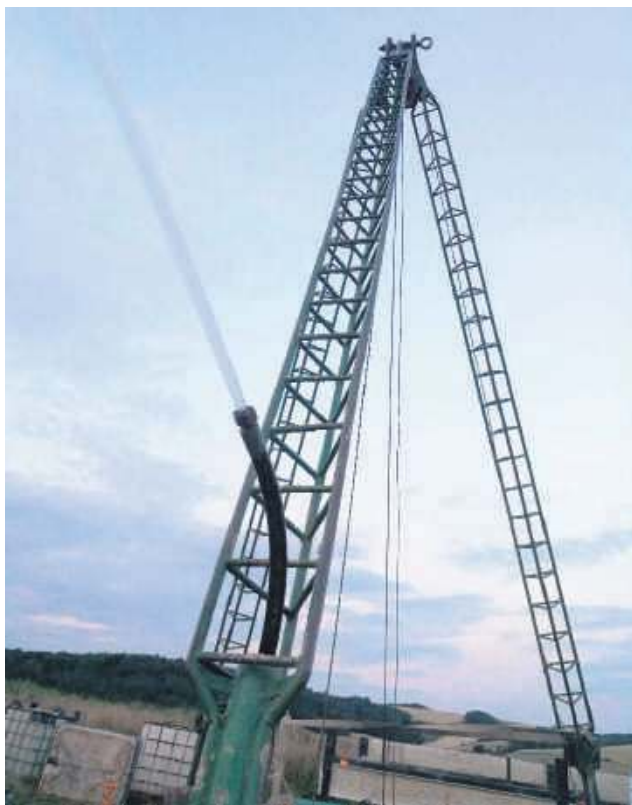
Odwiert studni głębinowej w miejscowości Gorajec-Zagroble. Fot. nadesłane
