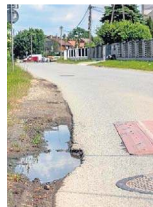
Przebudowa ulicy Rybitwy ruszy w październiku
