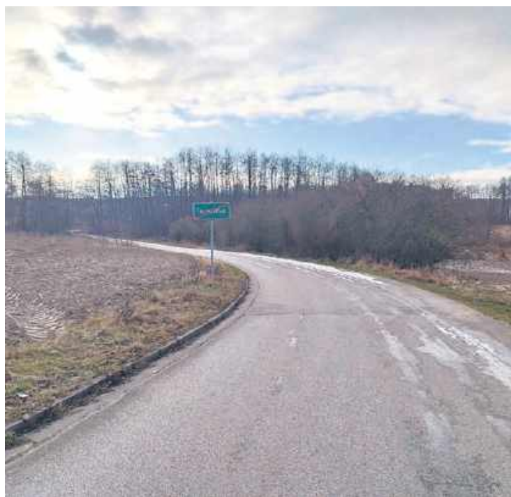
Jeszcze w tym roku droga w Tuchółce doczeka się modernizacji i to przy udziale środków zewnętrznych. Fot. UG w Kęsowie
