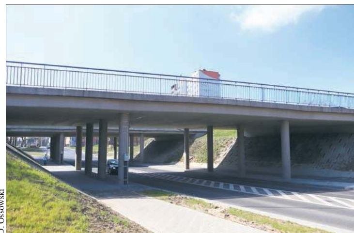
Po wykonaniu modernizacji
