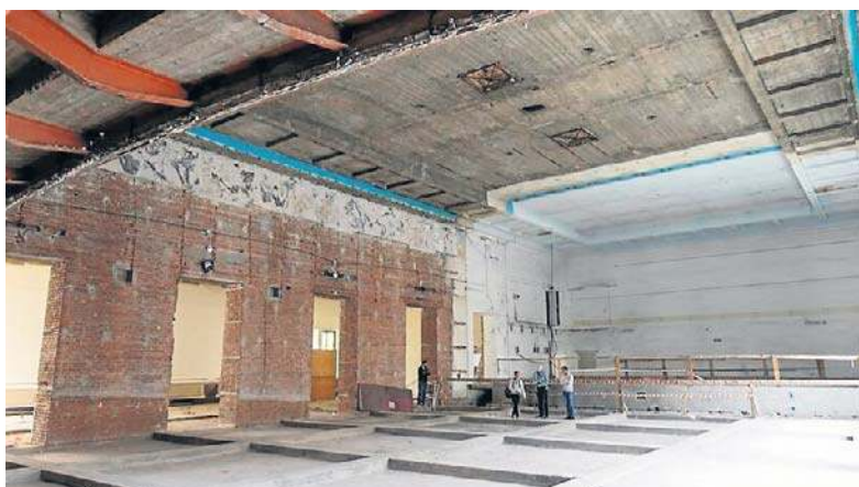
Sala koncertowa Radomskiej Orkiestry Kameralnej przechodzi kapitalną przebudowę. Zakończyły się prace rozbiórkowe.
