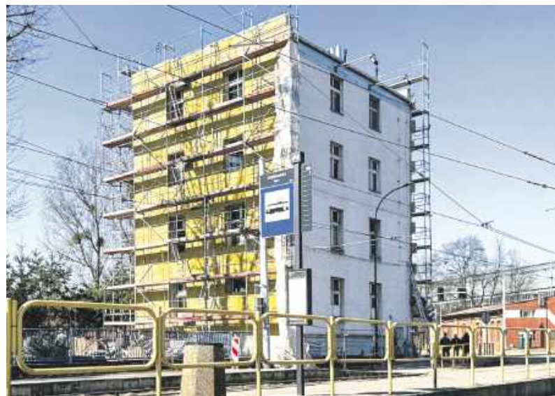
Po kapitalnym remoncie budynek znowu będzie przydatny
