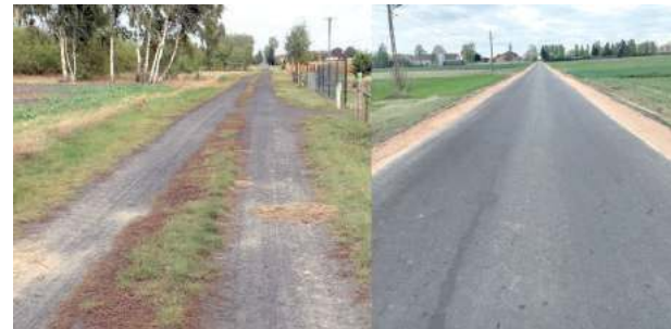
Kolejny kilometr drogi gminnej oddany do użytku. Tym razem jest to droga nr 101742L w Olszewnicy (zdjęcie przed i po remoncie)
