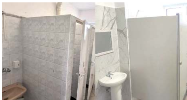
Pierwszy etap remontu sanitariatów zakończony. Już za chwilę rusza kolejny (zdjęcie przed i po remoncie)
