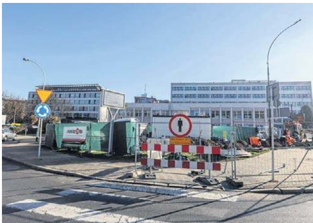
Budynek stanie w narożniku między ul. Moniuszki, Zygmuntowską i al. Ciepłńskiego
