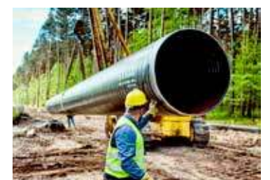
Gazociąg Goleniów-Police został ukończony
