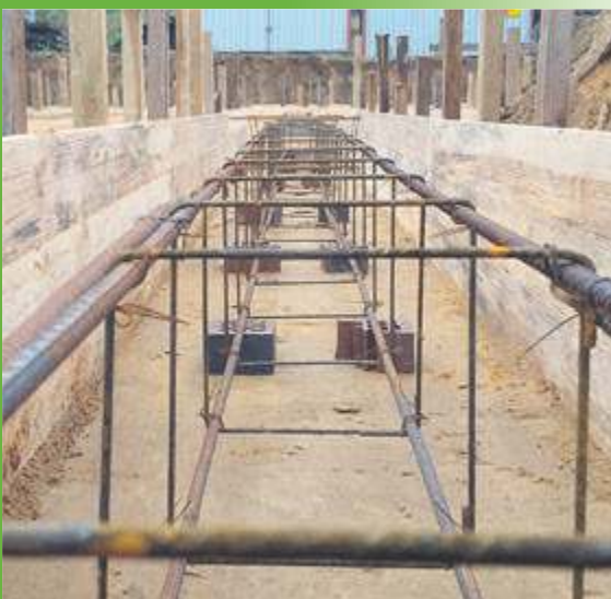
Zbrojenie ław. Fot. nadesłane
