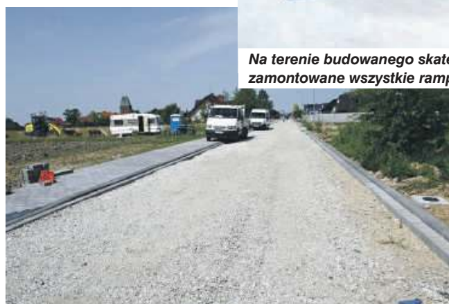
Do zakończenia prac na ul. Wiosennej w Krynicy pozostało położenie nawierzchni bitumicznej
