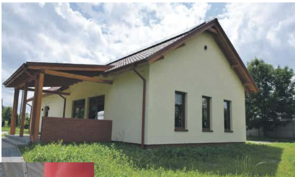
Świetlica wiejska w Tarnowcu
