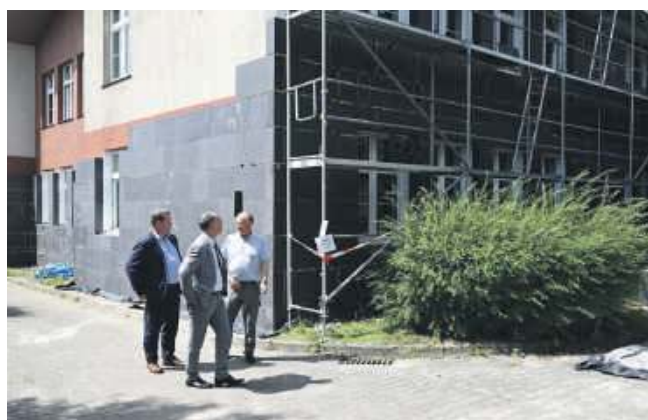
Prace termomodernizacyjne w Szkole Podstawowej w Krynicy
