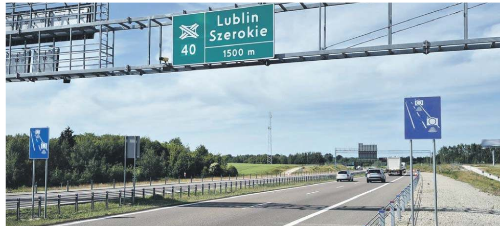
W czerwcu na drogach ekspresowych województwa lubelskiego uruchomiono dwa odcinkowe pomiary prędkości, w tym na 7,5 km drogi S19 w ciągu obwodnicy Lublina
