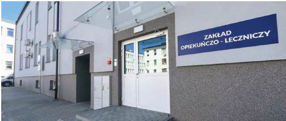
Inwestycja kosztowała łącznie ponad 11 mln zł. Zamojski Szpital Niepubliczny otrzymał na jej realizację ponad 9,1 mln zł dofinansowania z Krajowego Planu Odbudowy.
