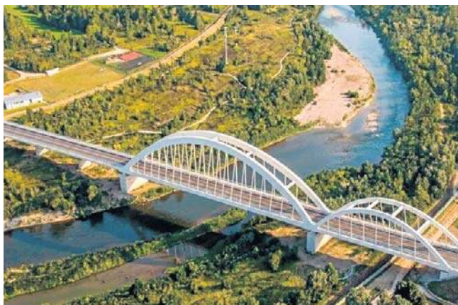
Tak ma wyglądać nowy most, który powstanie na Dunajcu i połączy Nowy Sącz z gminą Chelmelec
