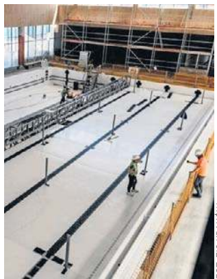
Trwa montaż niecek basenowych z ruchomym dnem
