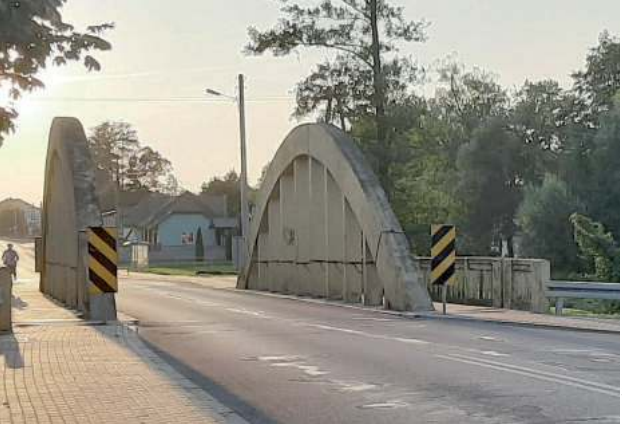
Most przy ul.Lubelskiej w Biłgoraju w końcu doczeka się modernizacji?
