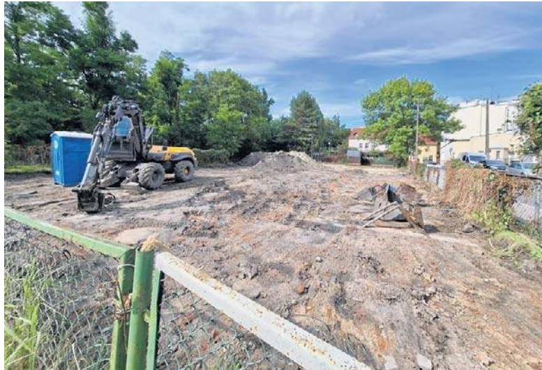
Rozpoczęły się już prace porządkowe na terenie dawnego targowiska przy ul. Skoczylasa
