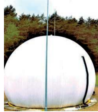
Wodociągi Chrzanowskie od ponad 25 lat eksploatują biogazownię w oczyszczalni w Chrzanowie
