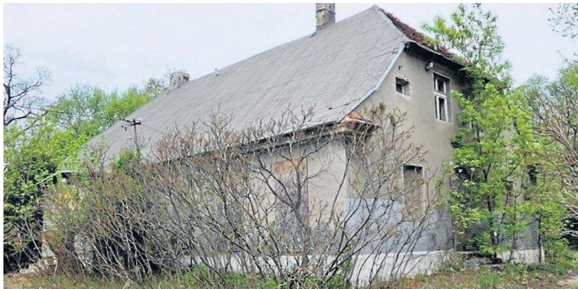
Tak dziś wyglądają zabudowania dawnego folwarku Katarzynka
