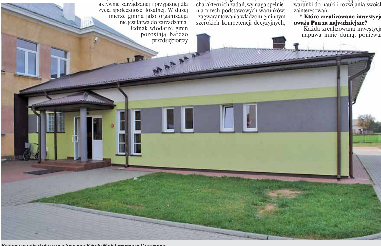
Budowa przedszkola przy istniejącej Szkole Podstawowej w Czerwonce
