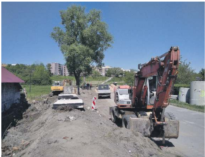
Modernizacji poddany zostanie ponad 1,5-kilometrowy odcinek drogi
