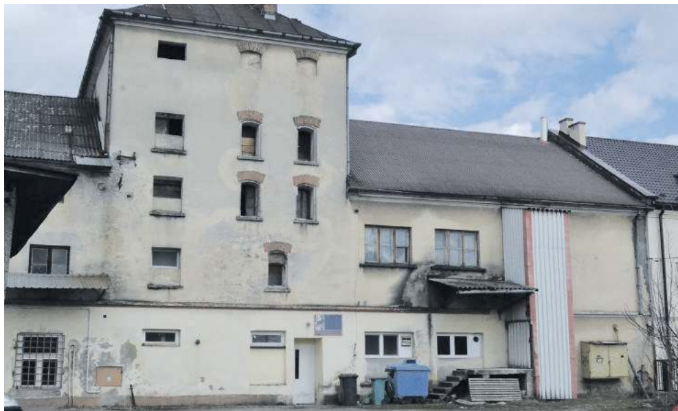
Władze Niska w zabytkowym budynku chciały zlokalizować Miejską Bibliotekę Publiczną. Niestety, obiektu nie udało się kupić
