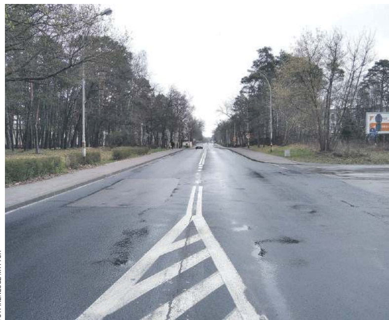
Modernizacji ma być poddany około kilometrowy odcinek ulic Mickiewicza oraz Żwirki i Wigury
