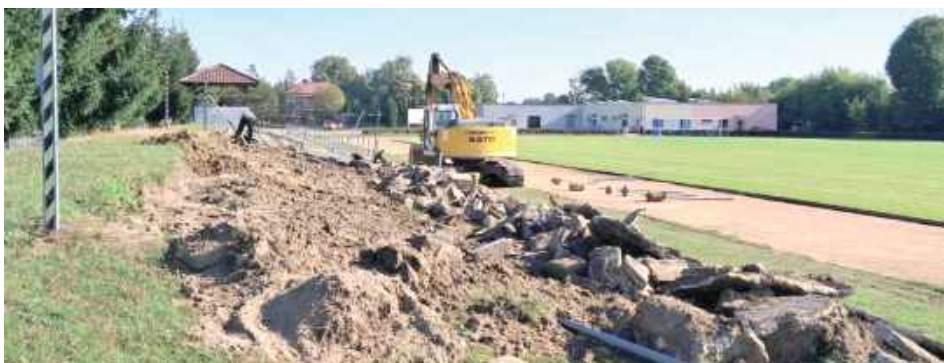
Dotychczasowe trybuny przy ul. Pszennej przeszły do historii
