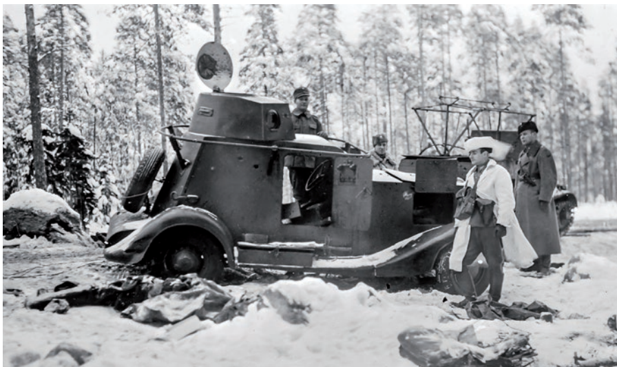
▲ Samochód pancerny BA-20M (wyposażony w radiostację 71-TK-1, widoczna antena poręczowa) porzucony przez załogę w rejonie Tolvajärvi, 18 grudnia 1939 roku. Na drugim planie widoczny ciągnik gąsienicowy A-20 Komso-molec.
