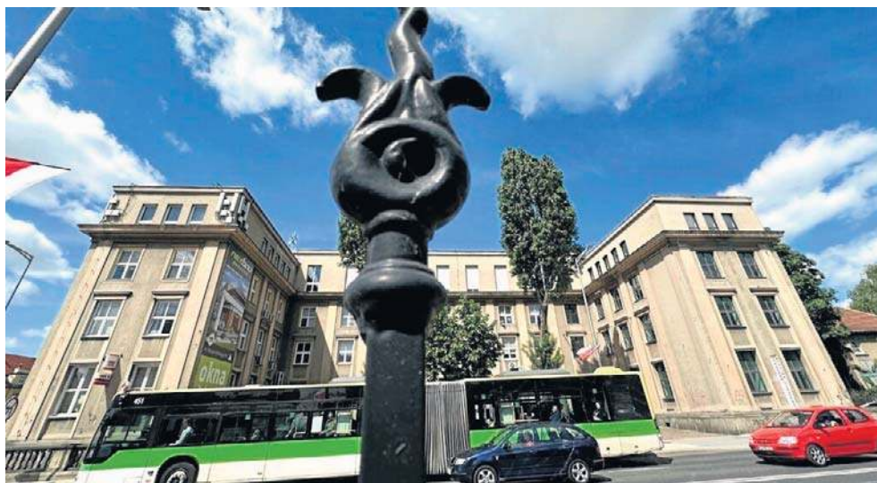
Mieszkańcy już teraz, przed modernizacją zgłaszają uwagi dotyczące obiektu... chcą być usłyszani zawczasu
