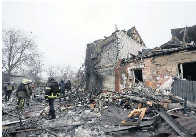
Ukraińscy ratownicy pracują na miejscu ataku drona na prywatny budynek w Charkowie. Co najmniej 10 osób zostało rannych
