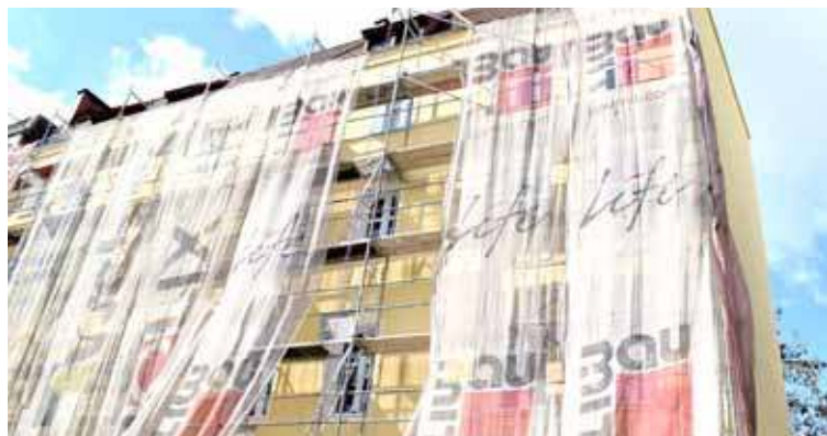
Niebawem kamienica przy Konopnickiej 10 odzyska dawny blask. Obecnie trwają prace związane z termomodernizacją budynku
