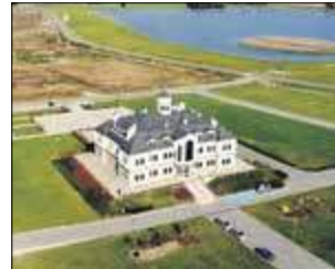
Teren w Kobylanach został już uzbrojony, jest doprowadzona kanalizacja, zostało wykonać drogi i oświetlenie. – Chcemy zacząć sprzedawać działki w Kobylanach, których mamy ok. dwustu – informuje wójt
