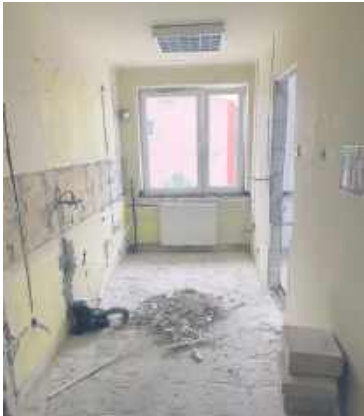
W budynku komendy dopiero teraz trwa remont części pomieszczeń
