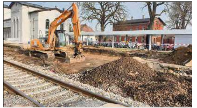
Tu będzie przejście pod torami.
