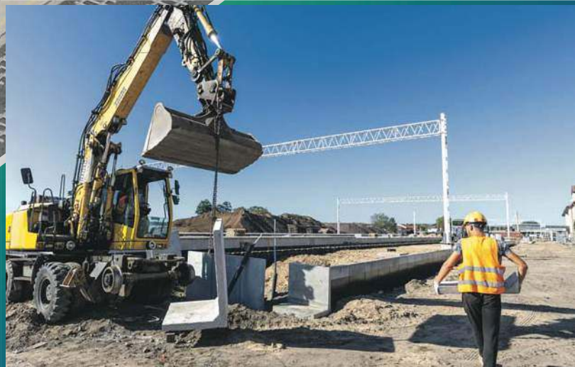
Montaż ścian peronowych
