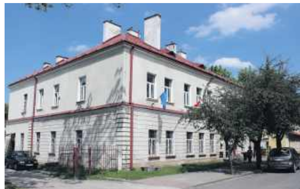
Budynek Poczty Polskiej w Nisku
