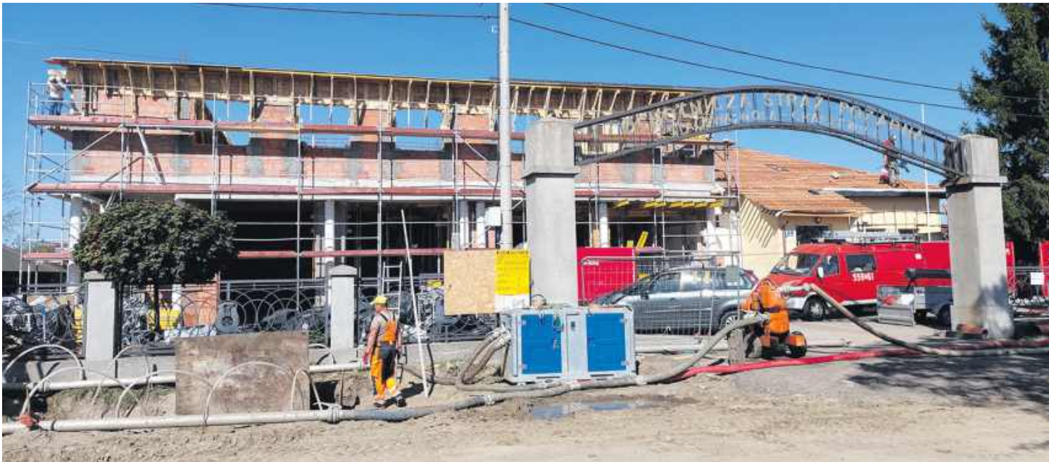
2 kwietnia odbyło się uroczyste wmurowanie kamienia węgielnego pod trwającą rozbudowę remizy dla Ochotniczej Straży Pożarnej w Stalowej Woli-Charzewicach
