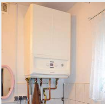
❶ Kompaktowy kocioł ma wbudowany zasobnik c.w.u. o pojemności 45 l.
