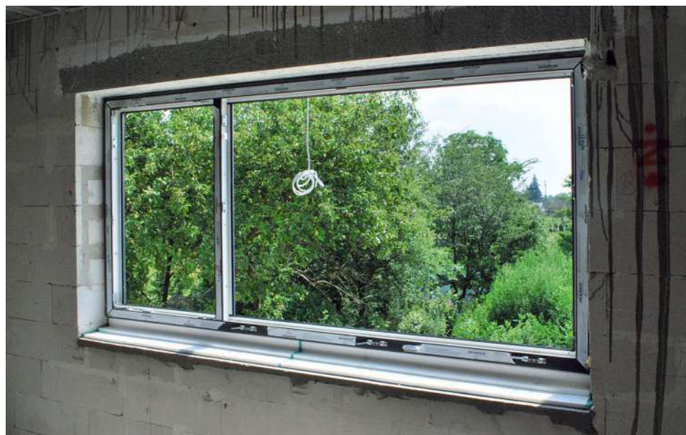
🔑 Tzw. ciepły parapet eliminuje przedmuchy i mostki termiczne. ALUPLAST
