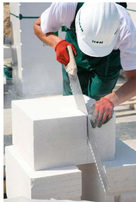
❶ Wykonawcy lubią beton komórkowy, bo jest lekki, a jego obróbka łatwa. H+H
