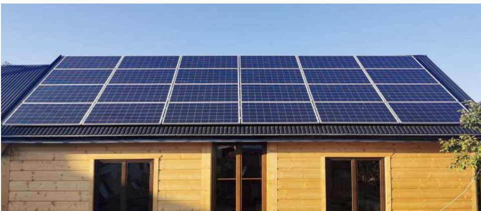
📍 Wszystkie panele na jednej połaci dachu i dokładnie tak samo nasłonecznione to idealna sytuacja. SOLEKO
