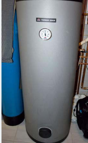
❷ Stojący zasobnik c.w.u. o pojemności 145 l.
