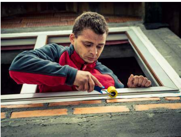
🔑 W zalecanym montażu warstwowym piankę zabezpiecza się od zewnątrz wodoodporną taśmą paroprzepuszczalną.
