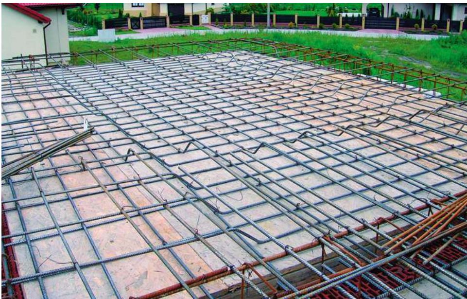
🟢 Strop monolityczny może mieć praktycznie dowolną rozpiętość. Jego wykonanie wymaga jednak doświadczenia i dużej ilości drogiej dziś stali. Aby ułatwić sobie pracę można użyć płyt typu filigran, pełniących rolę szalunku traconego. STALEXPORT
