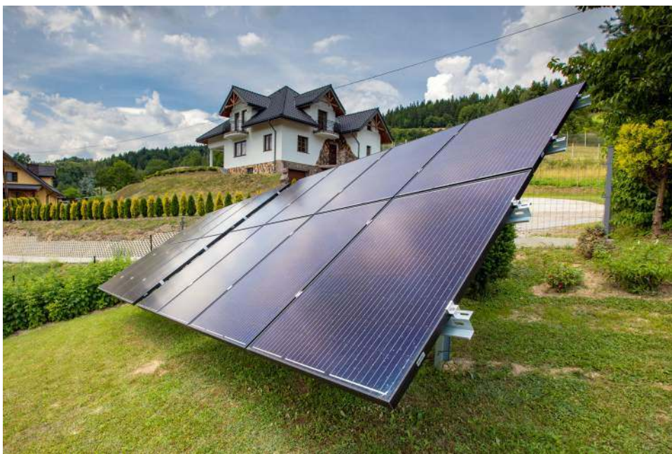
📍 W przypadku paneli na wolnostojącej konstrukcji wsporczej zastosowanie wersji dwustronnej warte jest rozważenia. COLUMBUS ENERGY
