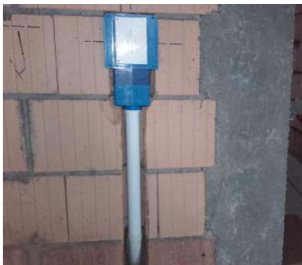
Kaseta gniazda ssącego stosowana w systemie Hide-A-Hose. TOPVAC
