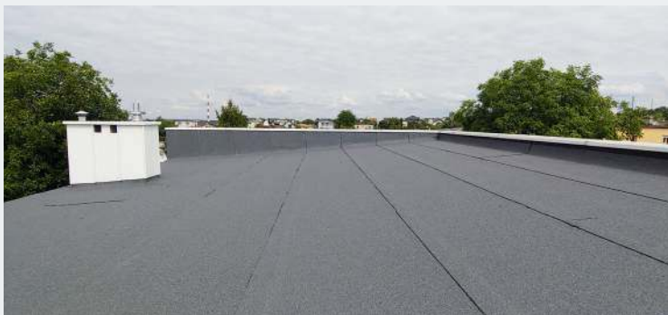
Dachy ocieplono płytami PUR i wykończono papą.
