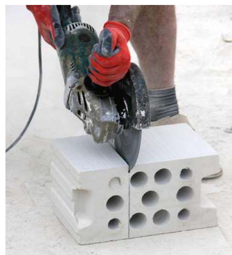
🔧 Silikaty są twarde, do ich cięcia stosuje się np. szlifierki kątowe. J. WERNER
