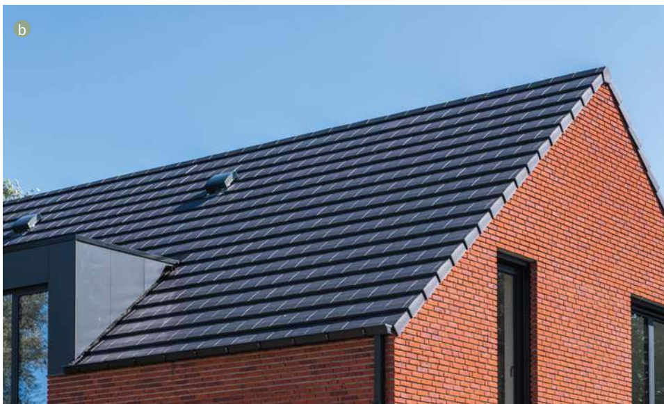
📌 Dachówki ceramiczne i betonowe „na oko” naprawdę trudno odróżnić. Tu nowoczesne, płaskie w odcieniach szarości: betonowa (a BMI BRAAS) i ceramiczna (b WIENERBERGER).
