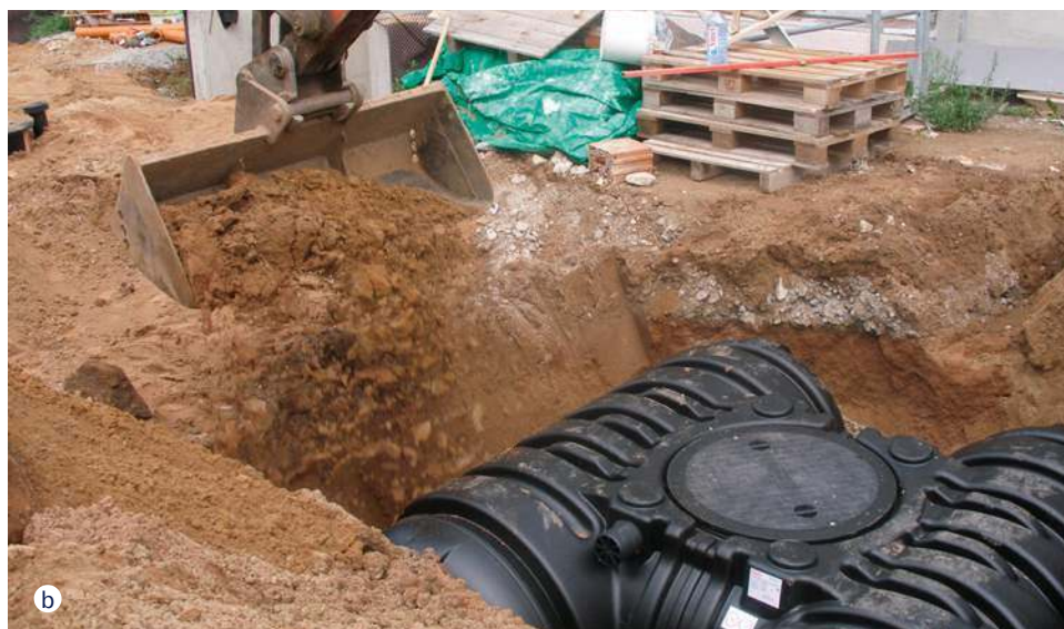
Osadzanie podziemnego zbiornika na wodę wykonanego z betonu (a gizo) i zasypywanie modelem z tworzywa (b ROTH POLSKA).
