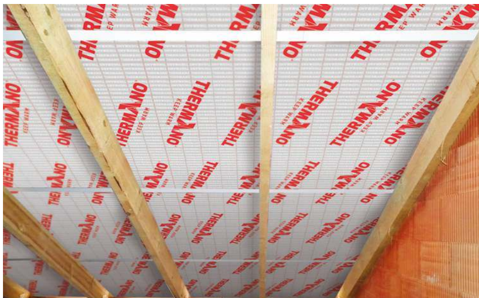
◻ Z wytrzymałych i odpornych na wilgoć płyt można ułożyć tzw. izolację nakrokwiową. THERMANO
