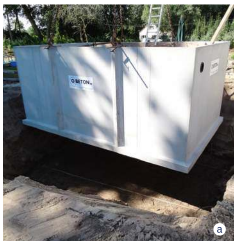
Osadzanie podziemnego zbiornika na wodę wykonanego z betonu (a gizo) i zasypywanie modelem z tworzywa (b ROTH POLSKA).
