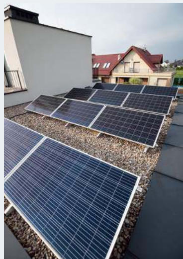
Na dachu garażu zamontowano 12 ogniw fotowoltaicznych.
