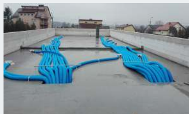
🔧 Przez otwory w żelbetonowym stropodachu wyprowadzono rury wentylacji mechanicznej.
