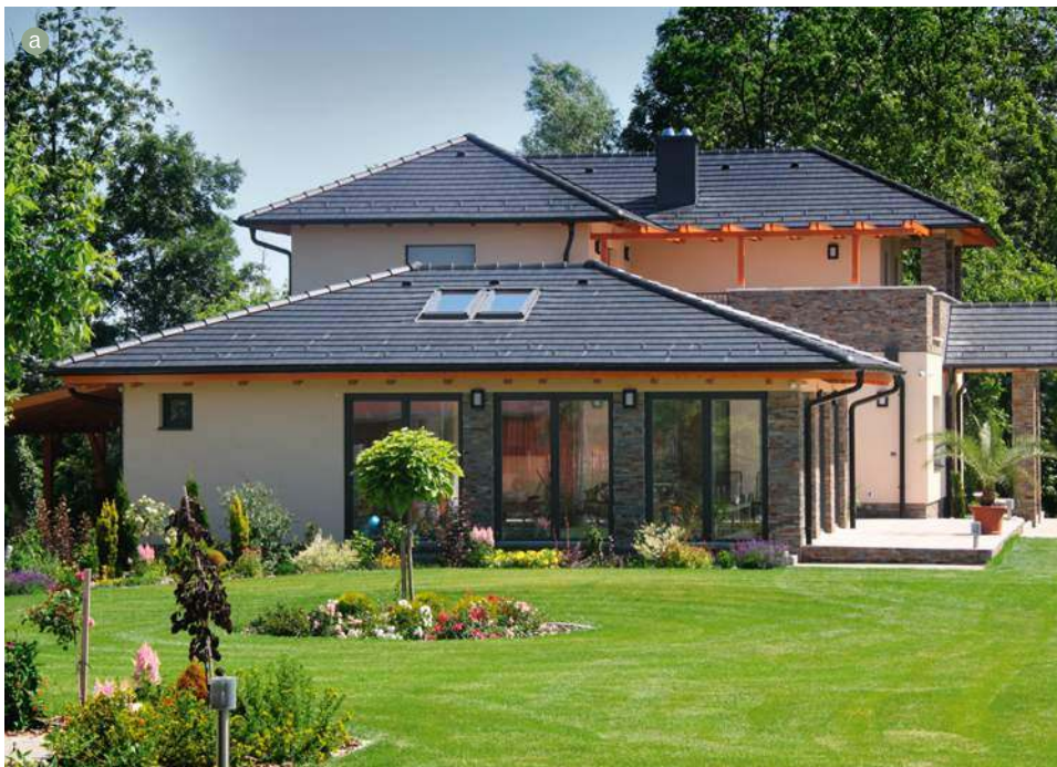
📌 Dachówki ceramiczne i betonowe „na oko” naprawdę trudno odróżnić. Tu nowoczesne, płaskie w odcieniach szarości: betonowa (a BMI BRAAS) i ceramiczna (b WIENERBERGER).
