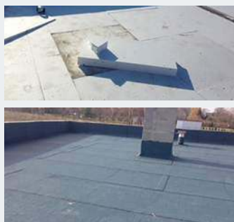
📍 Niewentylowany płaski dach na nachylenie około 3°. 📍 Kolejne etapy układania pokrycia.
