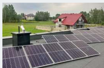
🔧 Do dachu umocowano dyblami 27 ogniw fotowoltaicznych.
