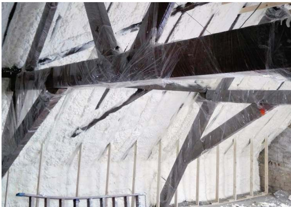
🔧 Elementy więźby, które docelowo mają pozostać odsłonięte, trzeba zabezpieczyć, zanim zacznie się nakładanie pianki. SOUDAL
