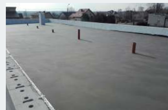
🔧 Przez betonową wylewkę (8 cm) z miksokreta wyprowadzono 5 rur do wentylacji warstwy styropianu.
