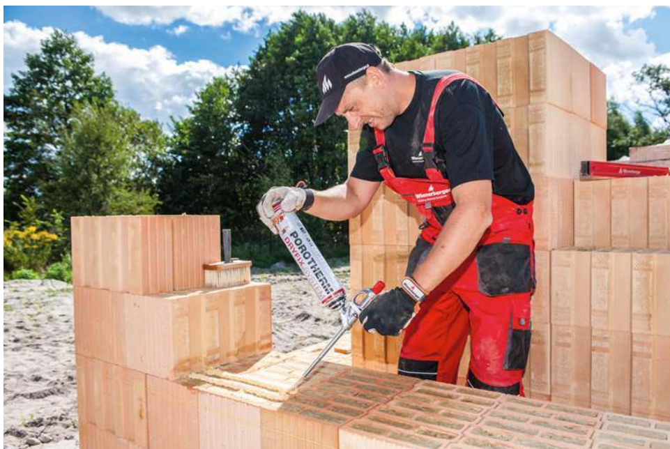
🔧 Budowanie po nowemu – pustaki z ceramiki (tu z wypełnieniem z wełny mineralnej) łączone pianą z puszki. WIENERBERGER
