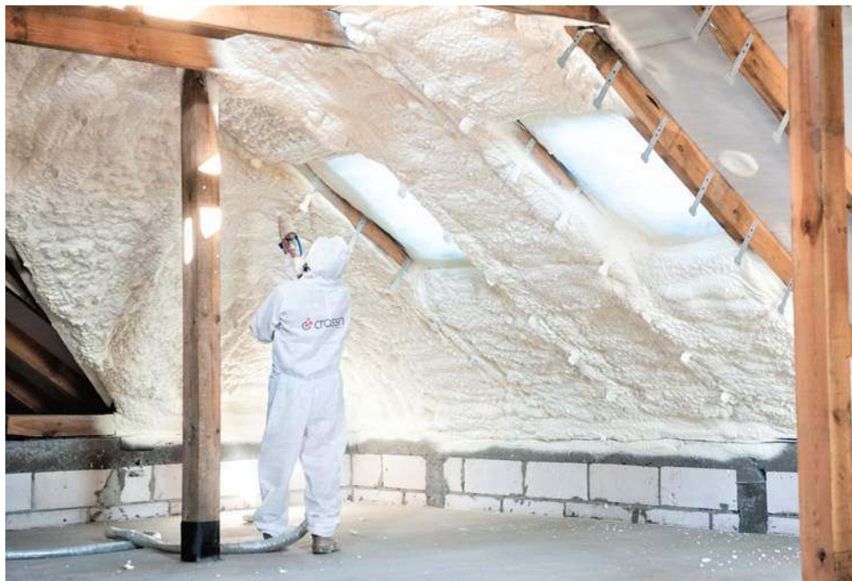
🔧 W domach jednorodzinnych piankę poliuretanową najczęściej wykorzystuje się do natryskowego ocieplenia poddasza. PCC PRODEX
