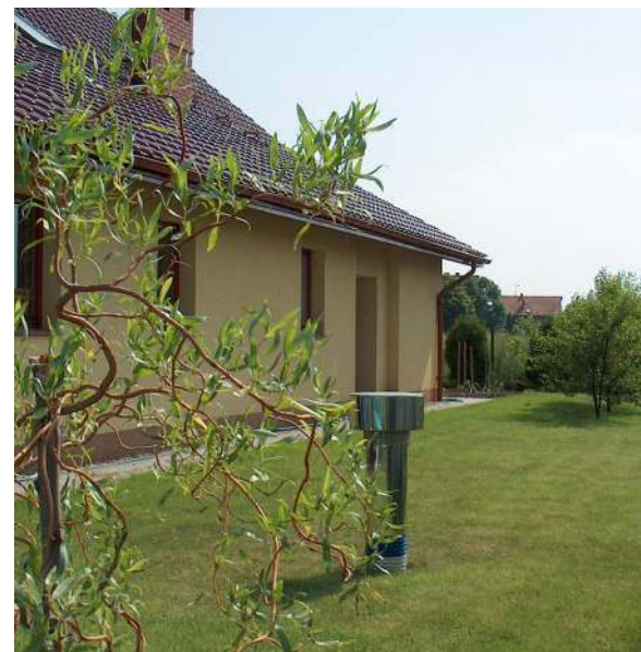
Czerpnia powietrza gruntowego wymiennika ciepła. PRO-VENT
