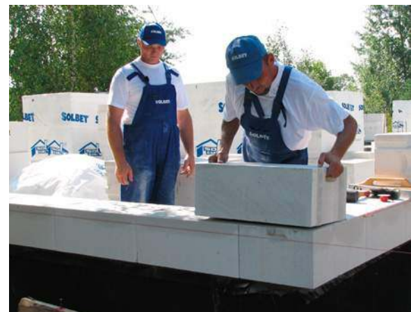
❶ Ściany z betonu komórkowego stawia się szybko – na 1\text{ m}^2 muru potrzeba 7 takich bloczków. SOLBET
