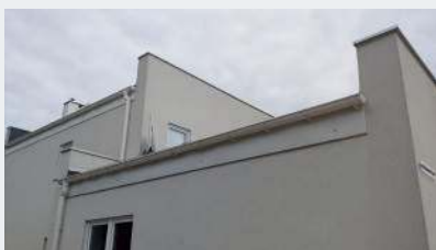
Dachy ocieplono płytami PUR i wykończono papą.
