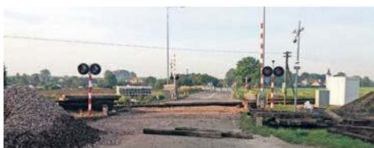
Droga wojewódzka pomiędzy Chojnicami i Niezychowicami jest nieprzejezdna.
