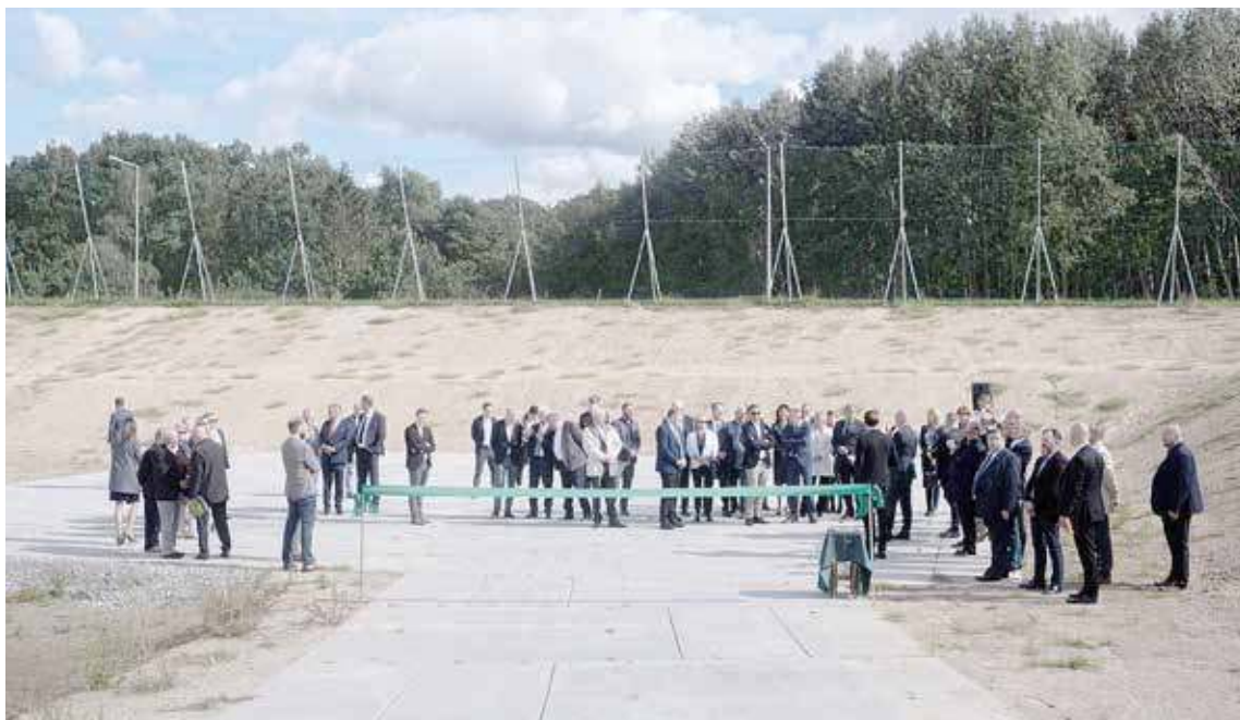
Koszt budowy nowej kwatery na odpady to ok. 20 mln złotych
