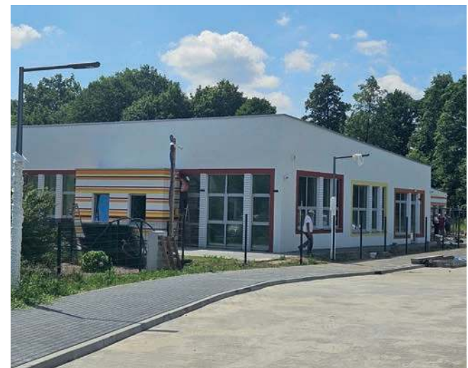
Gminny żłobek w Krzeszowicach powstaje przy al. Solidarności
