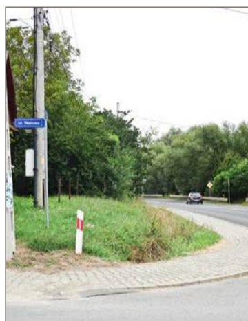
Kiedy rozpocznie się budowa ścieżki i kładki nie wiadomo.
