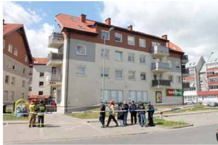
Budynek mieszkalny przy Armii Krajowej na Os. Pyrzyckim popękał w nocy z 11 na 12 maja
