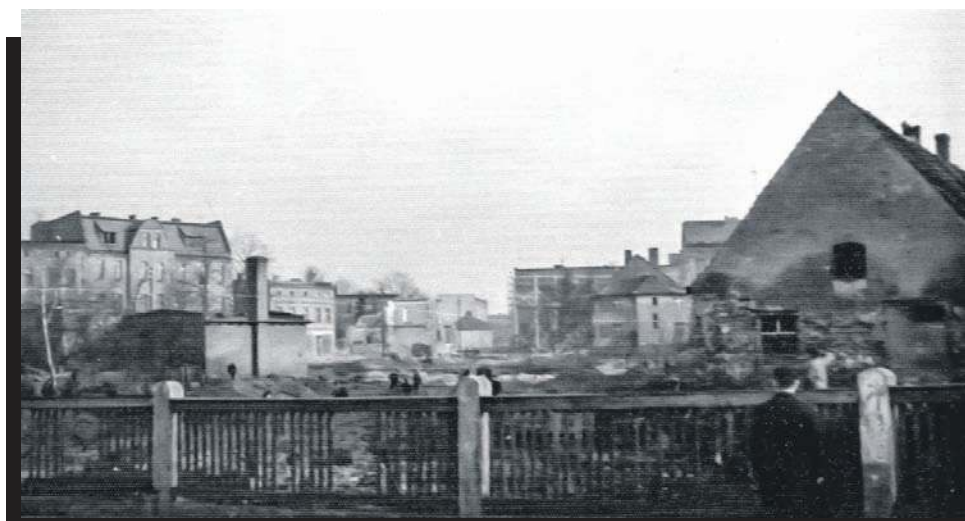
Zdjęcie zrobiłem od ulicy Kopernika w 1969 roku. Za moimi plecami był prowizoryczny, utopiony w błocie, przystanek autobusowy. Na wprost były ogrody. Na zdjęciu widzimy rozpoczęte prace przy niwelacji terenu pod budowę ulicy 3 Maja. Budynku po prawej już nie ma, po lewej budynki parterowe zostały wyrzucone.
